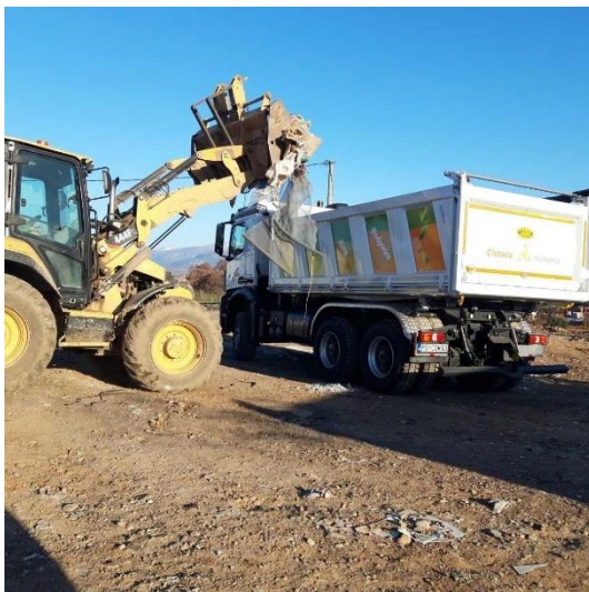
Sanacija neuređenih odlagališta
