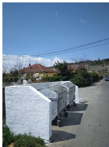
Izgradnja i uklanjanje grafita sa niša
